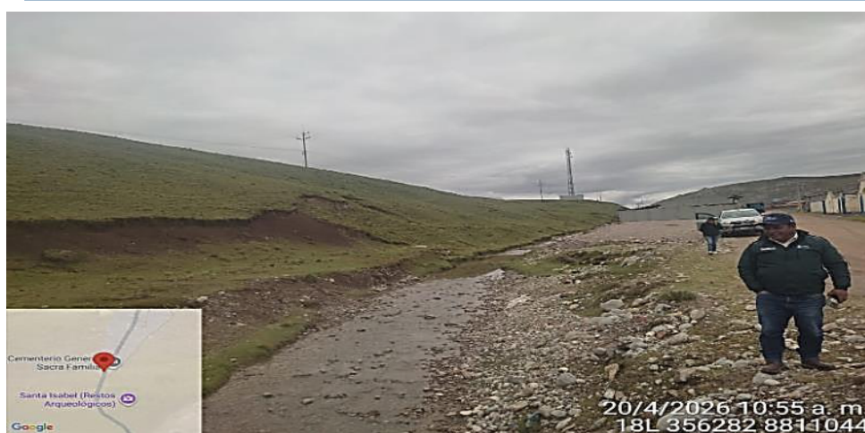
IMAGEN 03: SE VISUALIZA EN EL TRAMO FINAL, LA VIA CARROZABLE Y EL CEMENTERIO EN PELIGRO A INUNDACION POR DESBORDE DE LA QUEBRADA DONDE SE CONSTRUIRA UN MURO DE CONTENCIÓN DE CONCRETO ARMADO EN LA MARGEN IZQUIERDA COMO MEDIDA DE PROTECCION.
